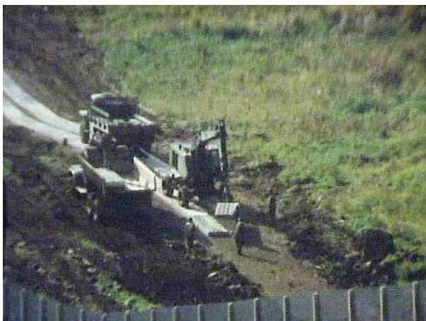
Bau des Kolonnenweges aus Betonplatten
