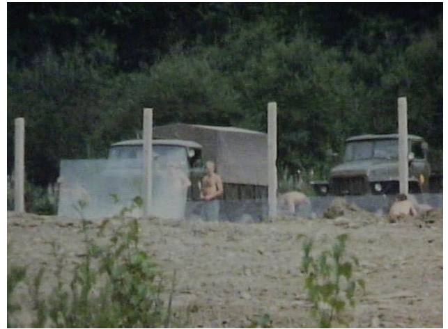
Umbau der Sperranlagen
