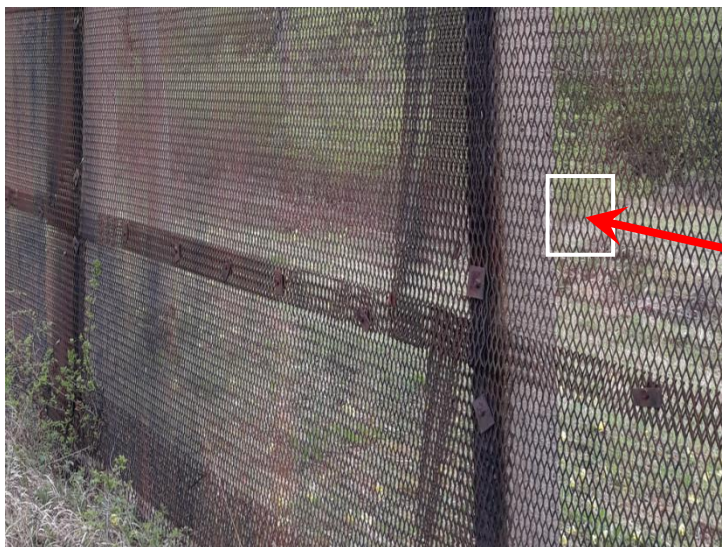
Metallgitterzaun (MGZ) aus Streckmetallplatten
