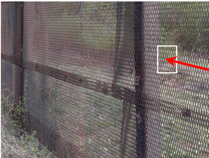
Metallgitterzaun (MGZ) aus Streckmetallplatten
