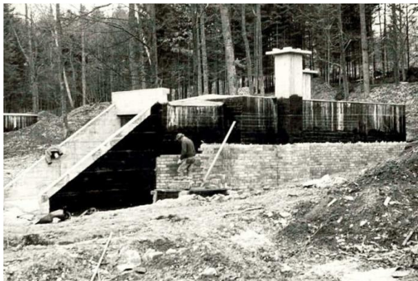
Bunker im Bau 1966
