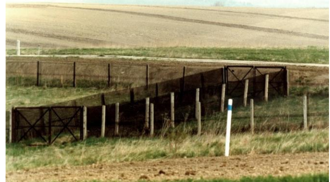
Zweireihiger Metallgitterzaun (MGZ) aus Streckmetall, Durchlass durch Minenfeld (Archiv: Erwin Ritter)
