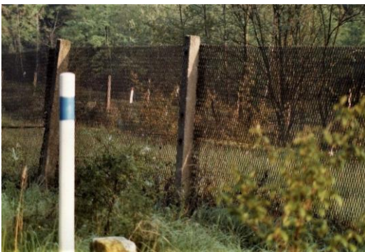
Zweireihiger Metallgitterzaun (MGZ) aus Streckmetall, Durchlass durch Minenfeld (Archiv: Erwin Ritter)
