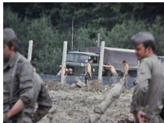
Bautätigkeiten am MGZ durch Pioniere (1977), vorne zwei Sicherungsposten (Archiv: W. Rügamer)
